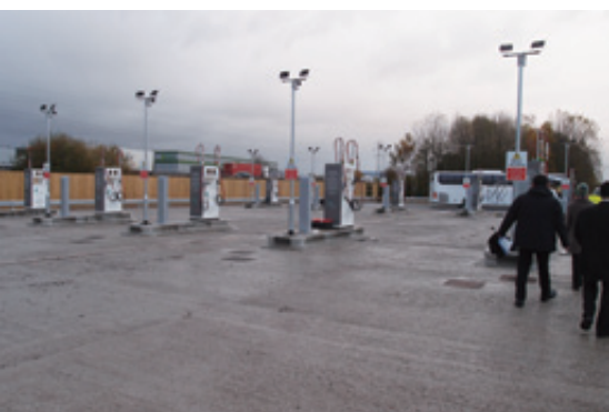
上：イギリス・リバプールの近郊に建設中のCNG fuels社のCNGステーション。バイオメタン100%の充填所
