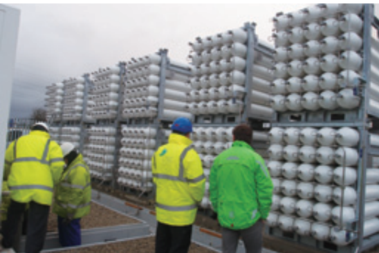
上：ディスペンサー（10基あり無人で操作される） 下：蓄ガス器（2550Lカードルを6基備える）
