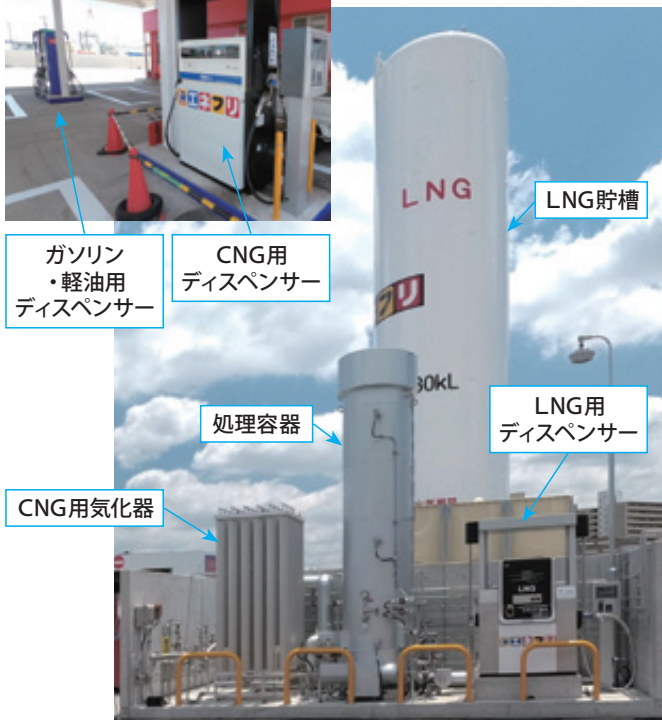
↓大阪南港地区に建設されたL+CNGスタンド（同様の設備が東京京浜地区にも建設されました）
