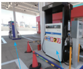
ガソリン・軽油用ディスペンサー CNG用ディスペンサー
