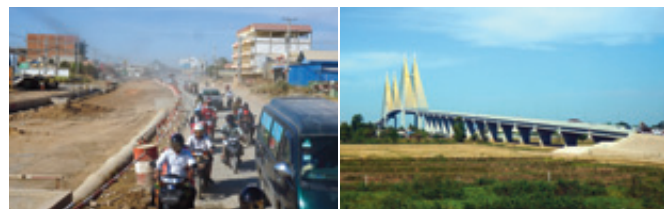
拡張工事の道路
