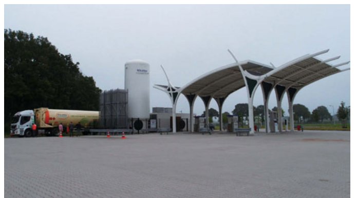
写真3 ROLANDE社のLNGステーション(オランダ・ティルブルグ)
