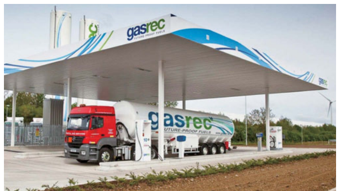
写真1 英国GasrecのLNGステーション
