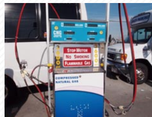
図4 充填用ディスペンサ：充填圧力は3600psi(250気圧)
