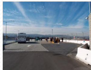
図3 CNG充填所外観
