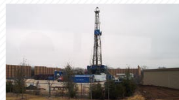
図9 掘削中の井戸：井戸は、最長で4,200m、深さ2,000mに及ぶ。技術開発により掘削日数は10日程度にまで短縮されている。
